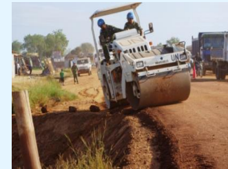
道路整備（日本隊） （UNMISS：南スーダン）
