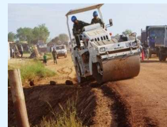
道路整備（日本隊） （UNMISS：南スーダン）
